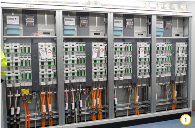
Distribution centre underneath Sechsläuteplatz
